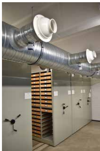
Tilluftsrör i centralmagasinet från klimatanläggningen
